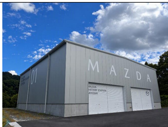
蓄電池システム (名称:MAZDA BATTERY STATION MIYOSHI)
